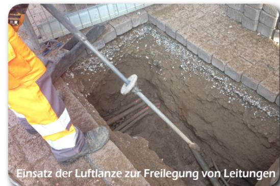
Da der Saugbagger nahezu berührungslos arbeitet, ist das Risiko einer Leitungsbeschädigung bei Arbeiten im Bereich von Medientrassen nahezu null. Das Sauggut wird durch den hohen Luftstrom eingesogen. Dieser Luftstrom stellt für die Leitungen keine Gefahr dar, da größere Leitungen in der Regel robust sind und dünnere Leitungen dem Luftstrom nur eine sehr kleine Angriffsfläche bieten.
